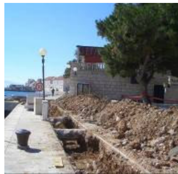
Kanalizacijski kolektori na Braču
